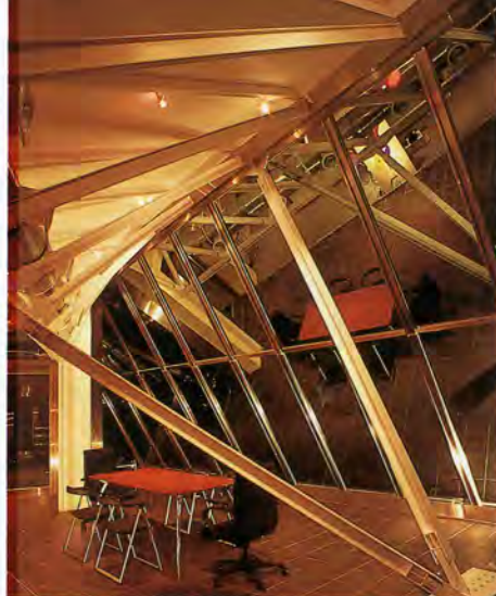
由入口接待區所見之傾斜V字型結構支撐與三角桁架的關係
